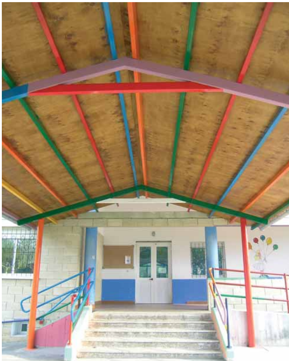
Acceso al edificio de Infantil
